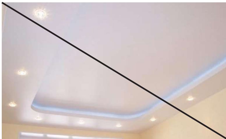
Плохо Многоуровневые гипсокартонные конструкции
